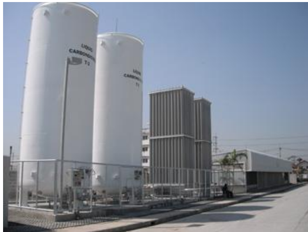
Sklop - kriogene posude s armaturom i isparivačima
